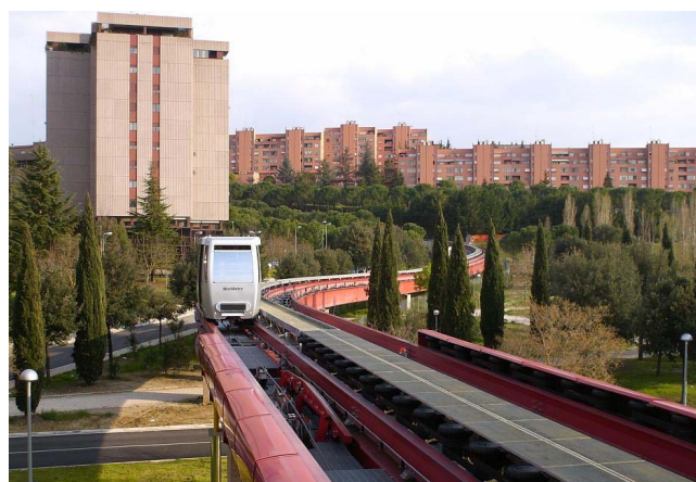
Vista di un tratto della Minimetrò di Perugia
