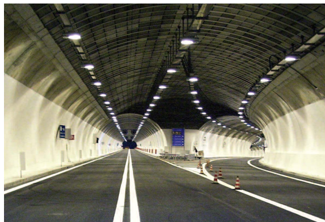
Vista di un tratto della galleria Montenegrone
